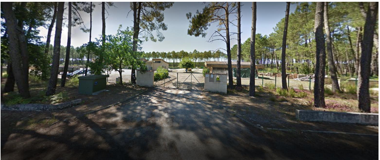
Figure 6 : Prise de vue 2 - Entrée existante de la déchèterie (source : Google street view)
